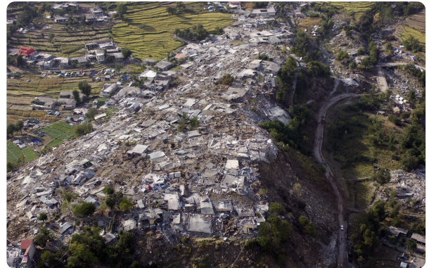
Zerstörte Häuser nach einem Beben (Balakot, Indien)
