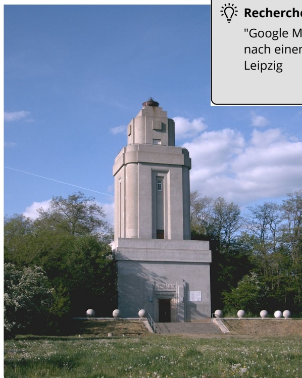
M6: Bismarckturm Lützschena-Stahmeln
