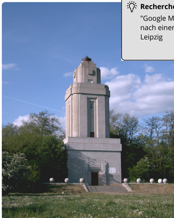
M6: Bismarckturm Lützschena-Stahmeln
