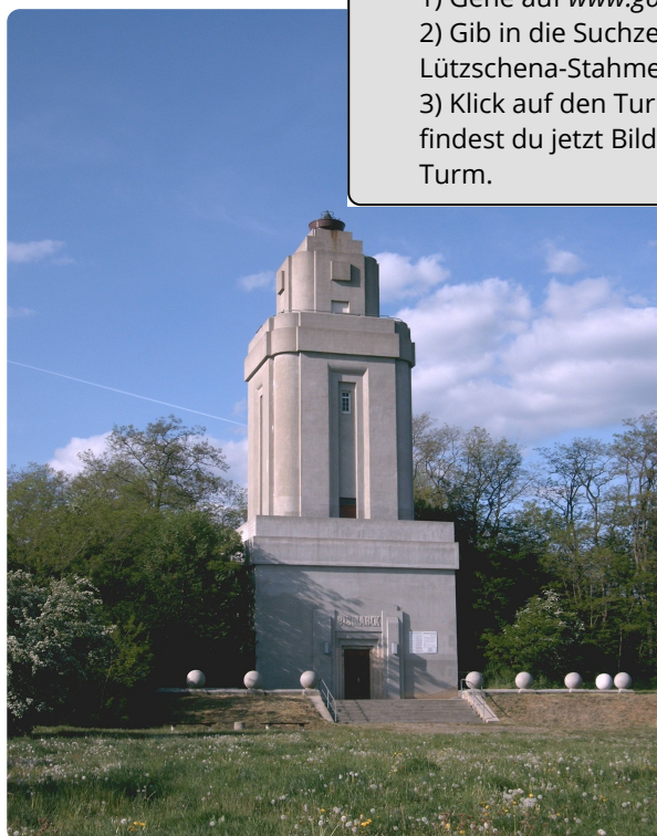
M6: Bismarckturm Lützschena-Stahmeln
