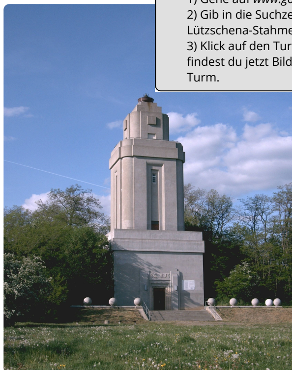
M6: Bismarckturm Lützschena-Stahmeln
