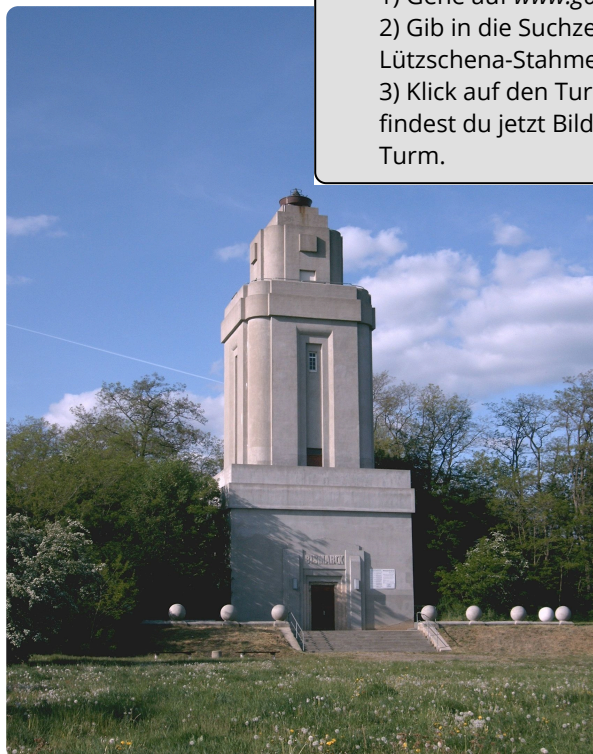
M6: Bismarckturm Lützschena-Stahmeln
