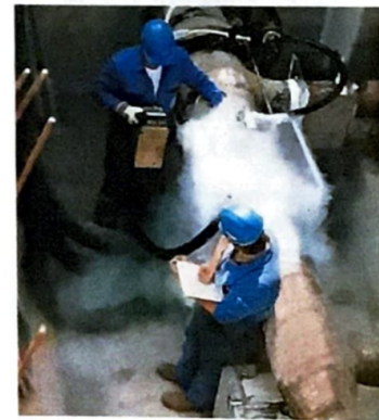
8 Stickstoff zum „Rohrfrosten“
