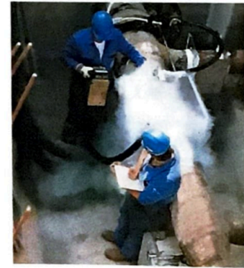
8 Stickstoff zum „Rohrfrosten“
