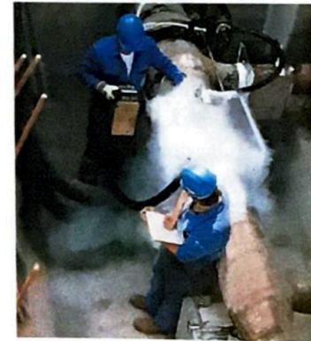
8 Stickstoff zum „Rohrfrosten“
