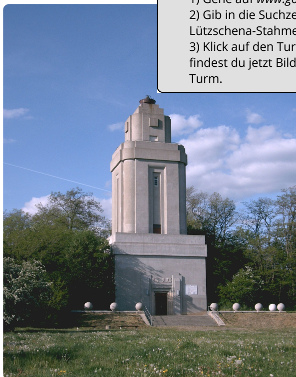
M6: Bismarckturm Lützschena-Stahmeln
