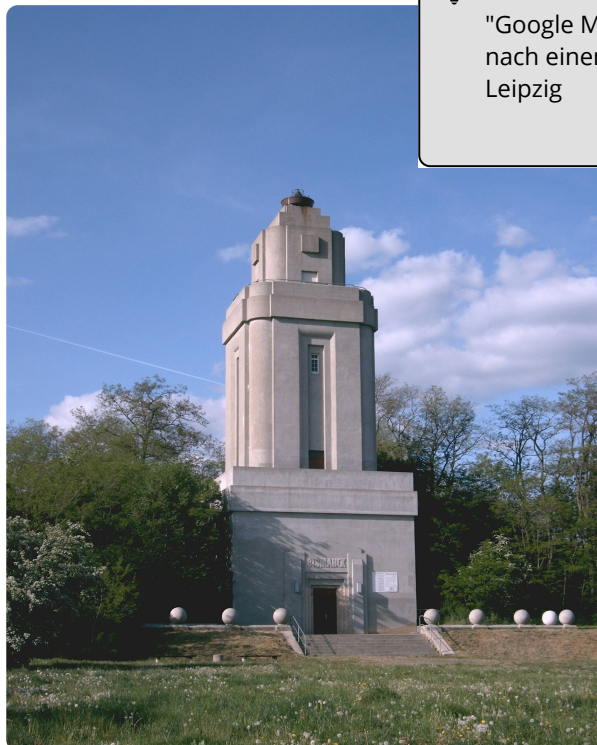
M6: Bismarckturm Lützschena-Stahmeln
