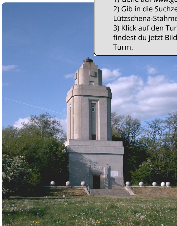
M6: Bismarckturm Lützschena-Stahmeln
