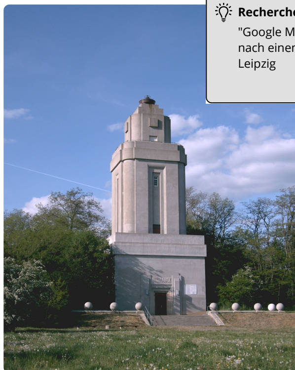
M6: Bismarckturm Lützschena-Stahmeln
