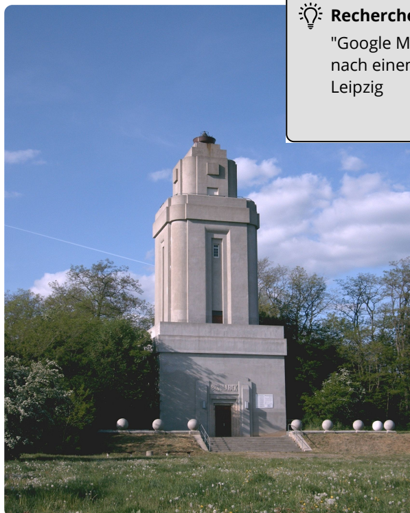
M6: Bismarckturm Lützschena-Stahmeln
