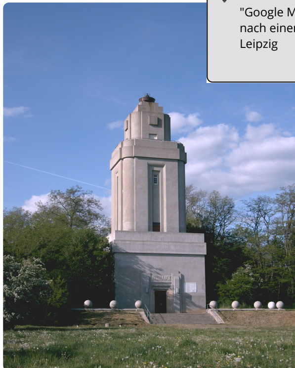
M6: Bismarckturm Lützschena-Stahmeln
