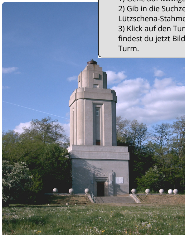
M6: Bismarckturm Lützschena-Stahmeln
