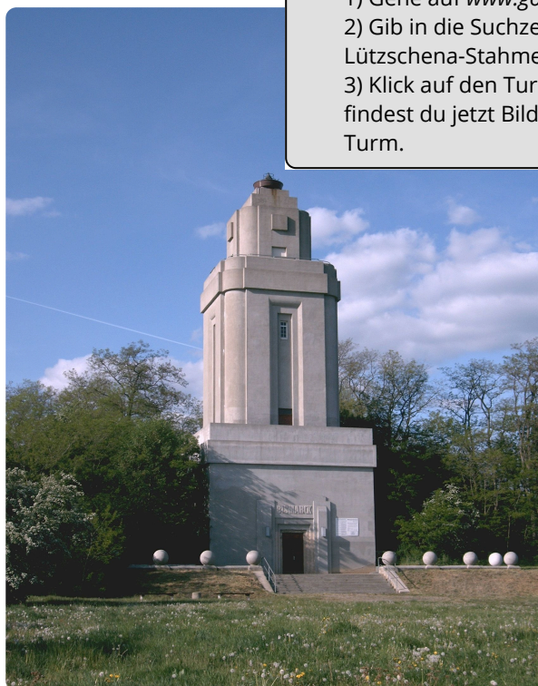
M6: Bismarckturm Lützschena-Stahmeln
