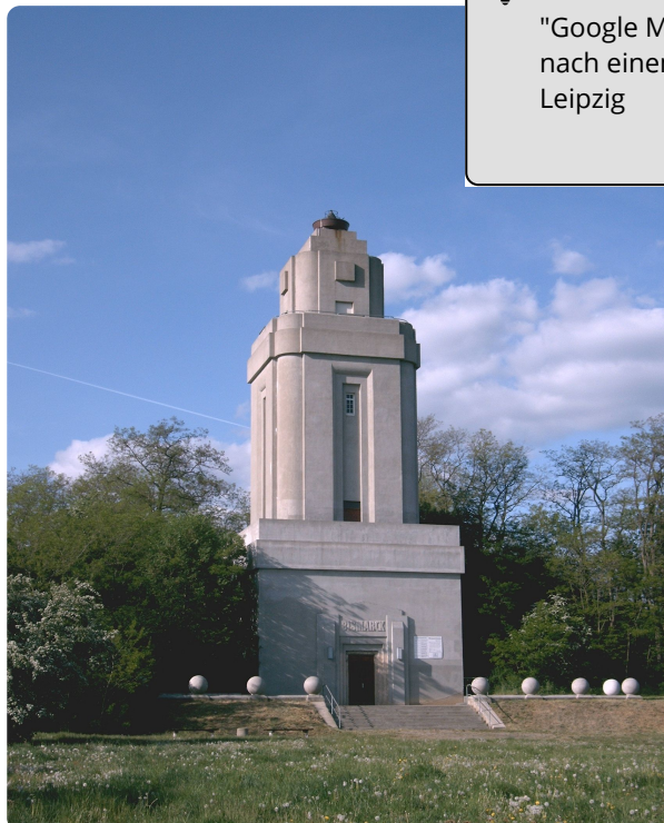
M7: Bismarckturm Lützschena-Stahmeln
