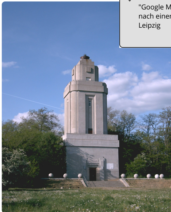
M7: Bismarckturm Lützschena-Stahmeln
