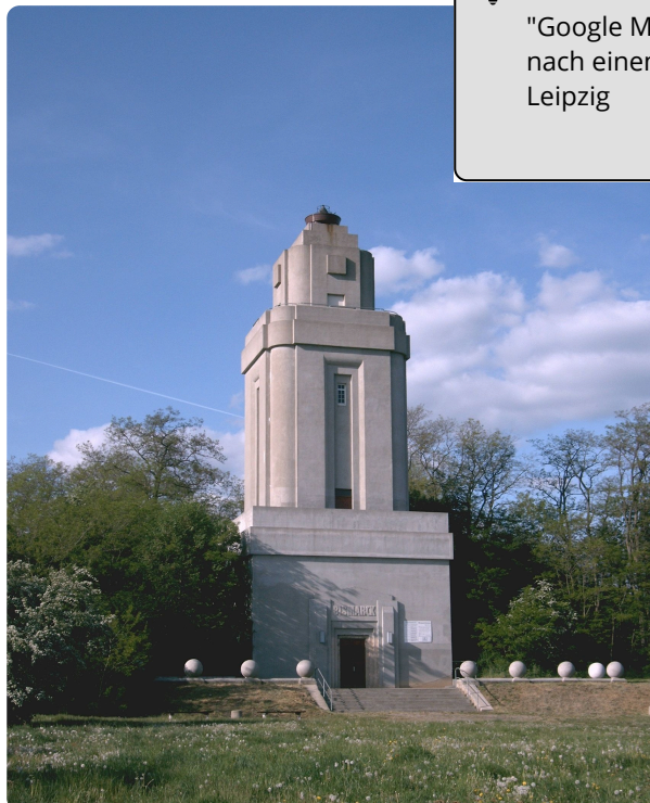
M7: Bismarckturm Lützschena-Stahmeln
