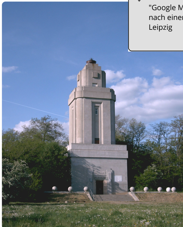
M7: Bismarckturm Lützschena-Stahmeln
